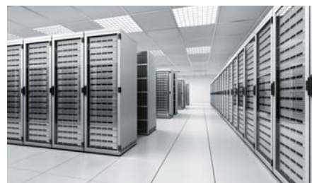
サーバールーム
