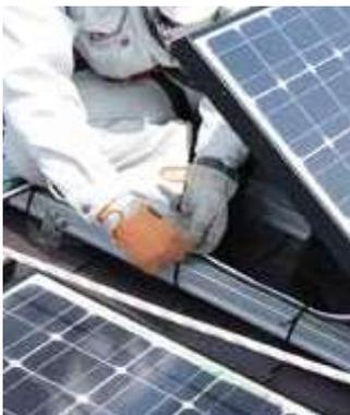
ガルバロックは、太陽光発電システムでのソーラーパネルの配線施工用として開発された結束バンドです。
