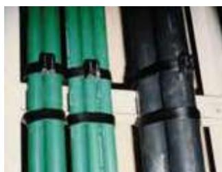
電設工事：電気設備垂直幹線結束例
