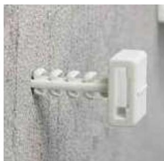
下穴を開けて指で押し込むだけでしっかりと固定できます。
