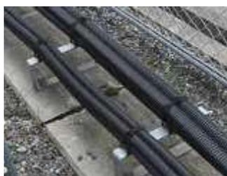
通信工事：携帯電話用給電線結束例
